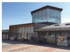
道の駅・まくらがの里こが 茨城県古河市大和田 2623
